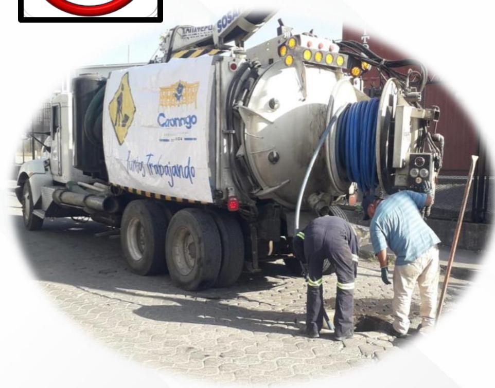
Se han recibido demandas realizadas por los usuarios sobre los azolores de drenaje, así como también los reportes realizados por el personal operativo sobre la existencia de un azolote, se realiza una evaluación por parte del personal operativo para valorar si se lleva a cabo un desazolve manual o a través de un equipo bacterior.
